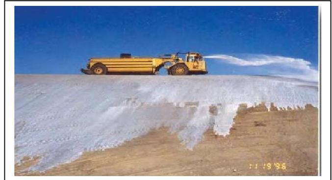
Cuando **Armor Guard** se aplica, penetra en el suelo uniendo las así las partículas y cementándolas en su lugar. El área tratada se vuelve muy resistente al desgaste y con su elasticidad única, asegura que la carretera resista la carga del tráfico vehicular, la lluvia, la nieve y otras condiciones que pueden desgastar la carretera. El producto no es peligroso y seca incoloro e inodoro.
